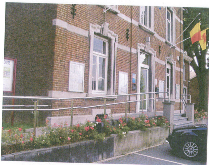
Nouvelle rampe d'accès à l'Administration communale
